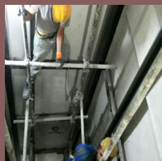
آب بندی چاله آسانسور
