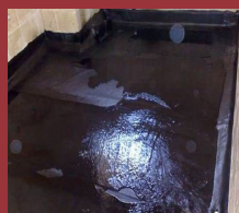
آب بندی سرویسهای بهداشتی
